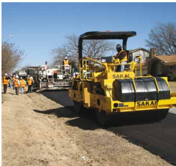
Хорошее уплотнение асфальтобетонной смеси PG 76-22 на ПБВ в Далласе, Техас, США, в условиях прохладной погоды (5°C)
